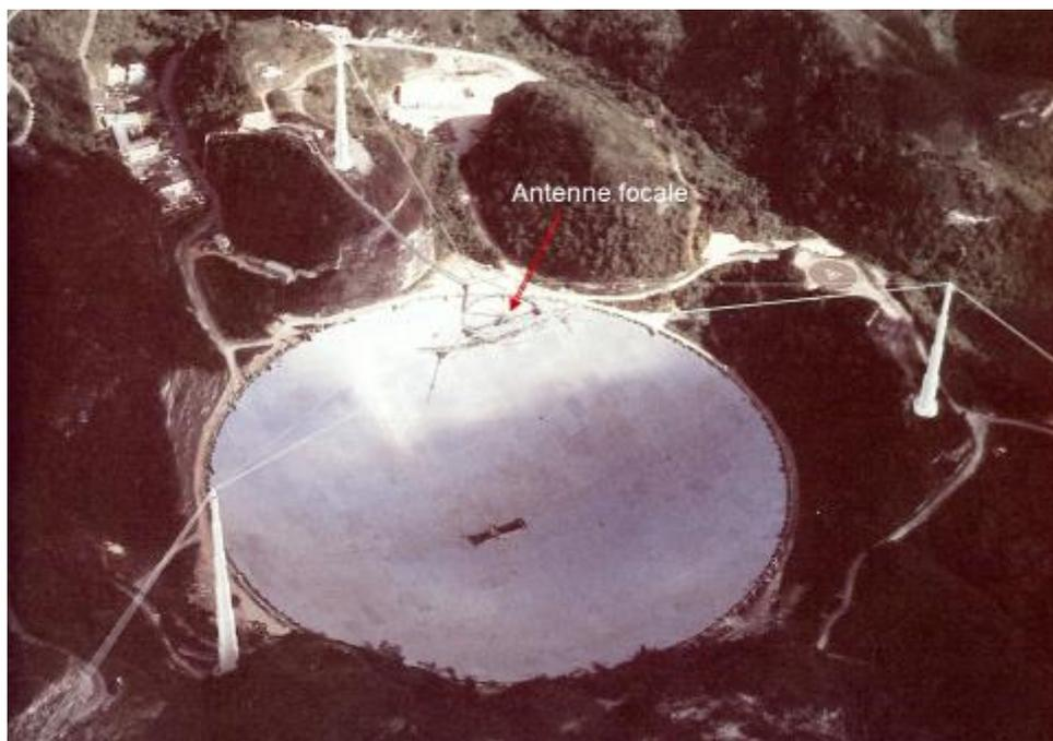
RADIOTELESCOPE D'ARECIBO diamètre: 300mètres
